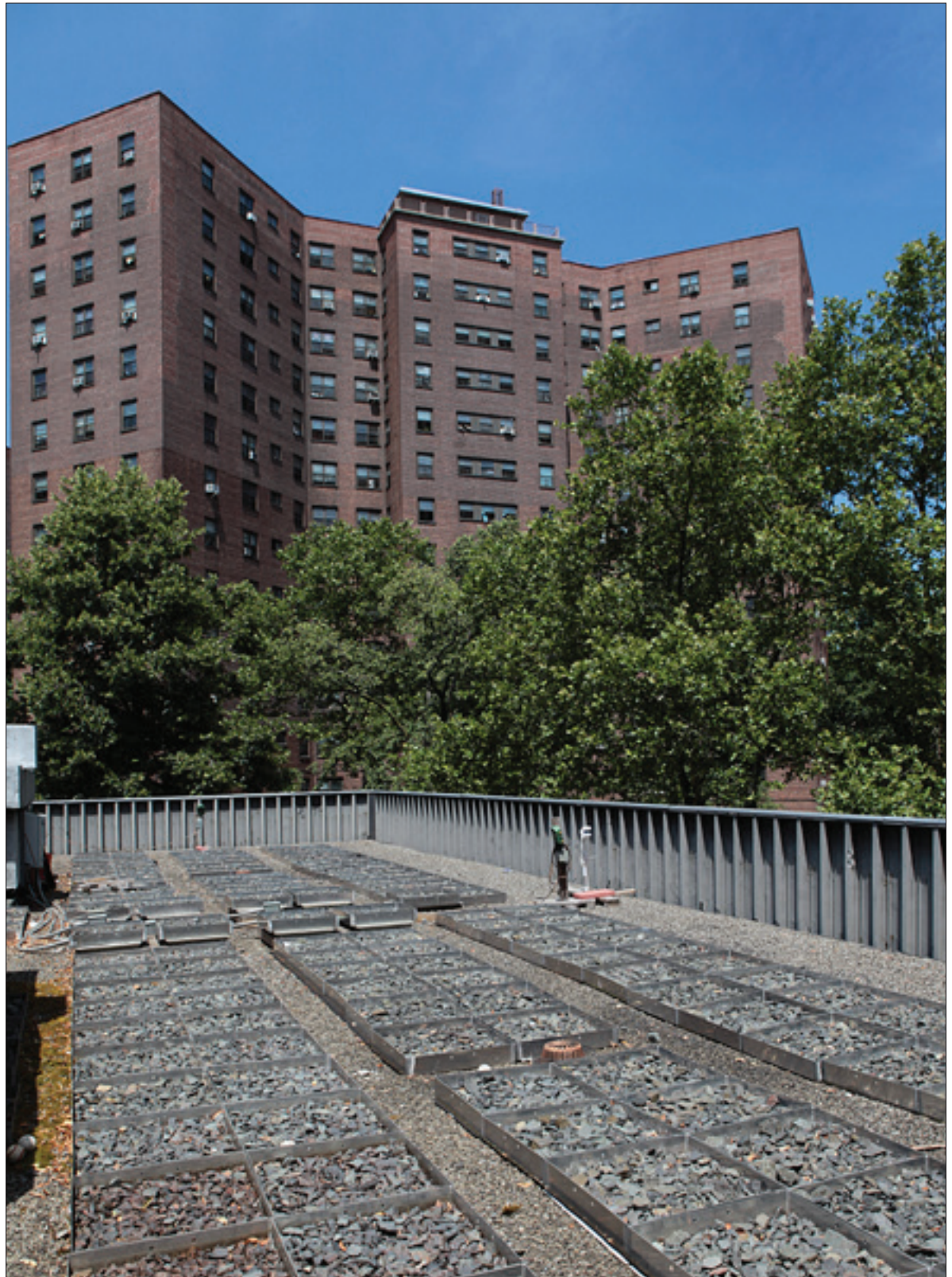
Проект регулирования стока дождевой воды в жилищном комплексе Bronx River Houses: «голубая крыша» удерживает и накапливает ливневые стоки
