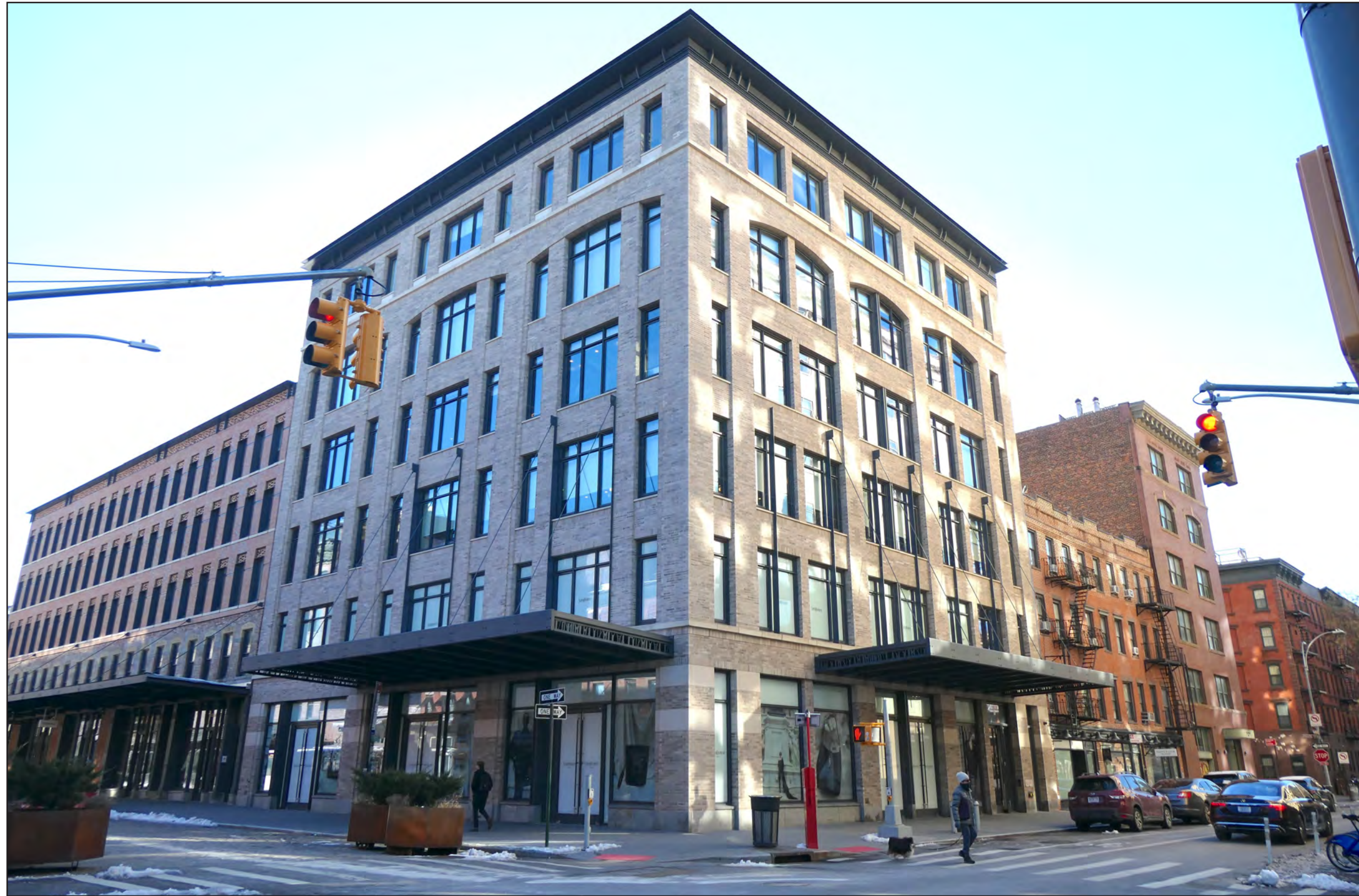
70-74 GANSEVOORT STREET - EXISTING CONDITION
