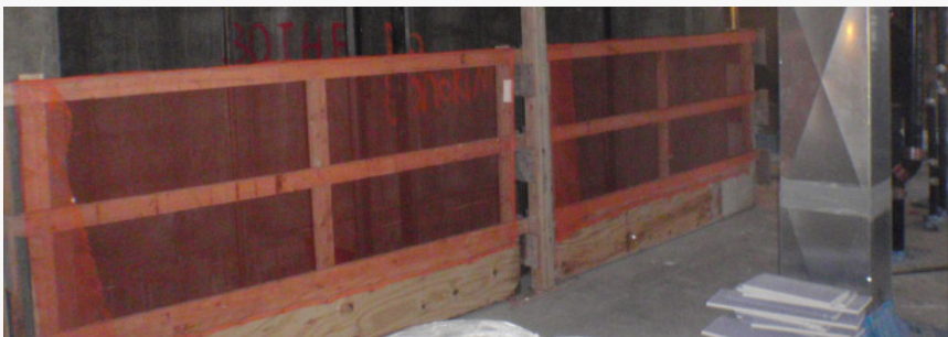
Protección para la apertura del hueco
