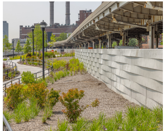
2023 年 Stuyvesant Cove Park 的植物和防洪墙
