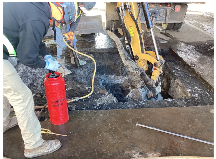
2023 年 11 月，进行试坑挖掘以定位 ConEd 公用设施管道 (PA1)
