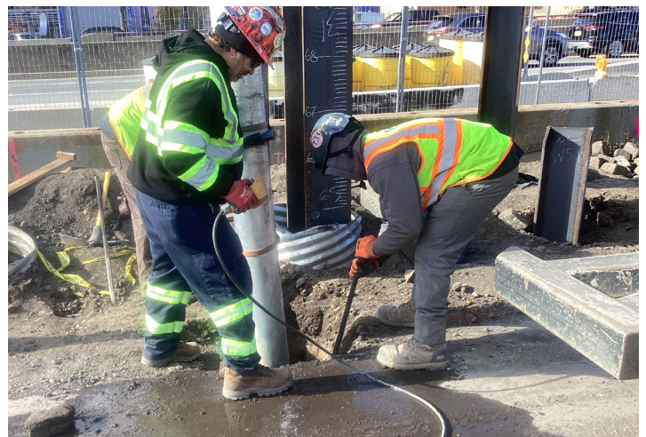
2023 年 11 月，工作人员正在挖掘试验坑 (PA1)
