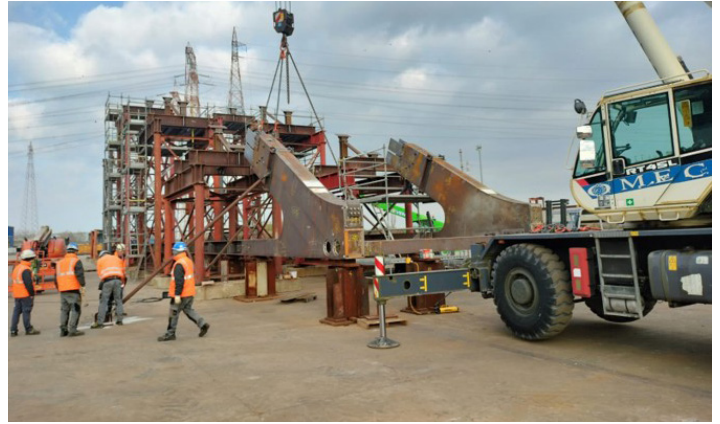
2023年11月，制造厂对Delancey街大桥进行试装
