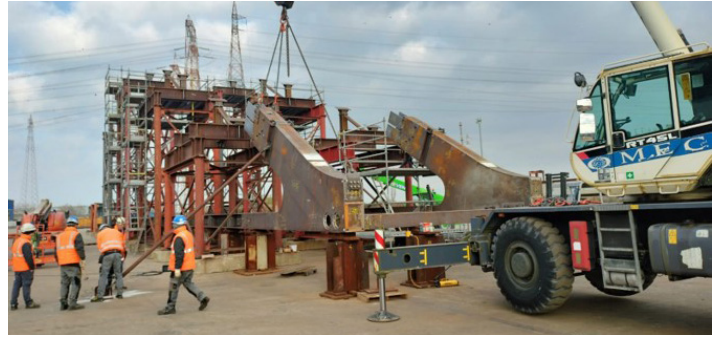
Prueba de ajuste del Delancey Street Bridge en las instalaciones de fabricación, noviembre 2023
