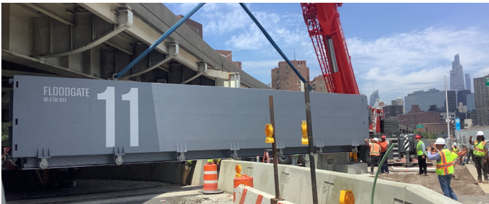
Instalación de la compuerta 11, julio 2023
