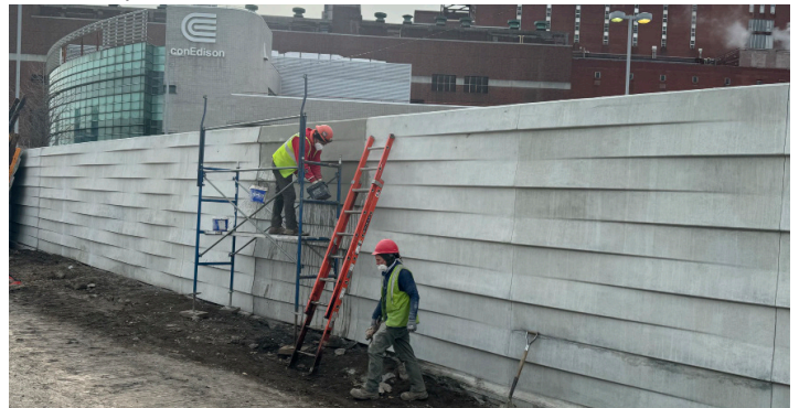
Obras de muro de contención al sur de Murphy Brothers Playground, diciembre 2023
