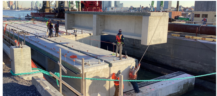
Instalación de piezas prefabricadas de explanada, diciembre 2023
