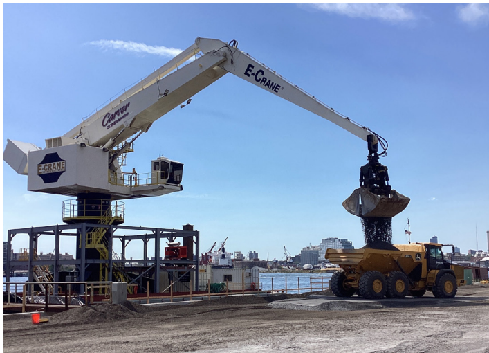
Grúa descargando materiales de relleno de una barcaza, septiembre 2023
