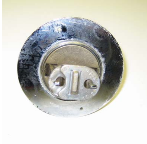
Flush Pendent Sprinkler
