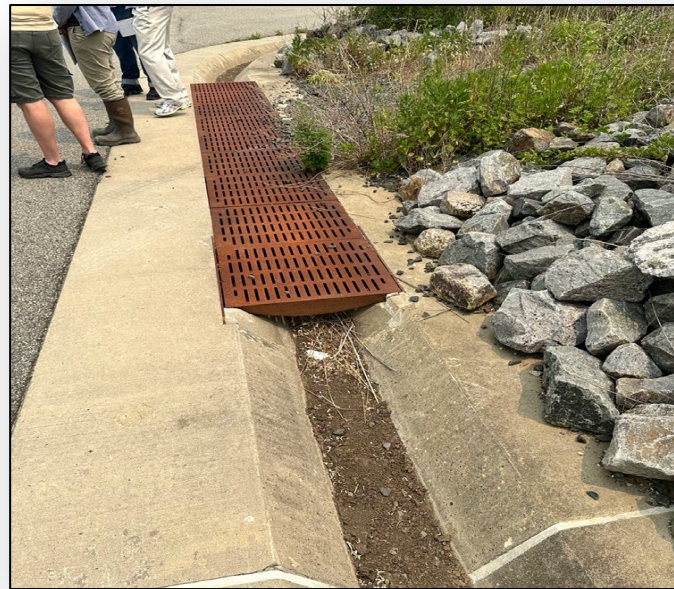
Ejemplo de canales cubiertos en la acera
