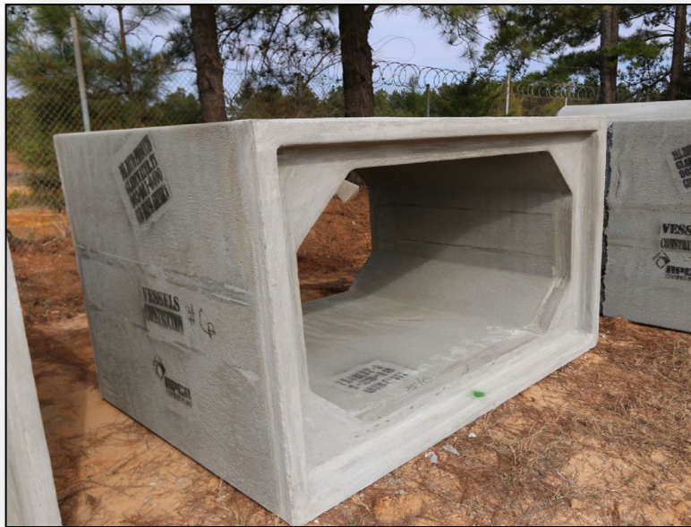
Ejemplo de alcantarillado tipo cajón
