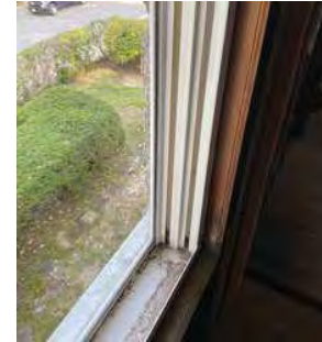
4 EXISTING DINE ROOM WINDOW-RIGHT SCALE: N.T.S.
