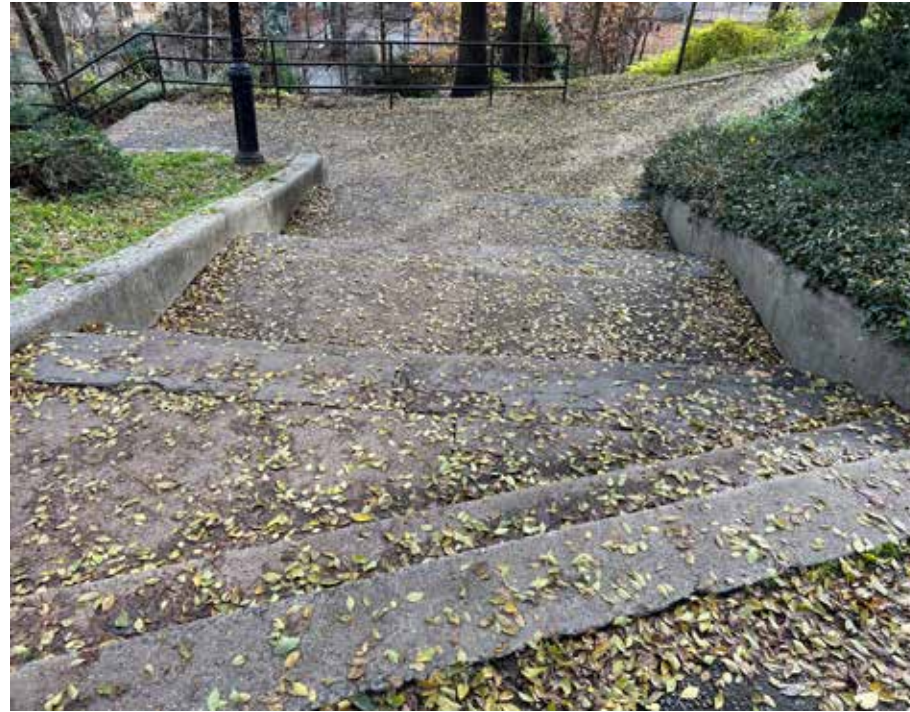
E. Concrete curbs
