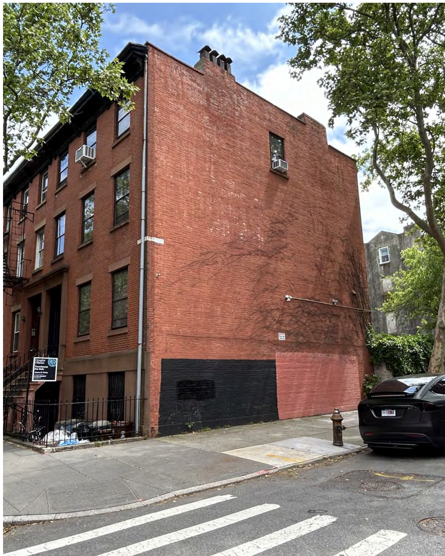
6 EXISTING REAR + SIDE + WALL (2024) LPC-006 SCALE: N.T.S.
