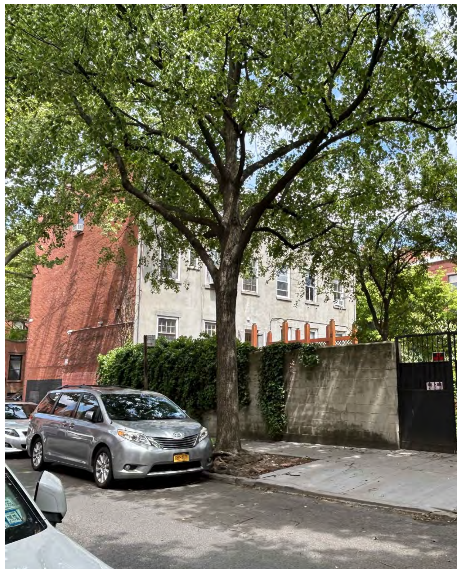
6 EXISTING REAR + SIDE + WALL (2024) LPC-005 SCALE: N.T.S.
