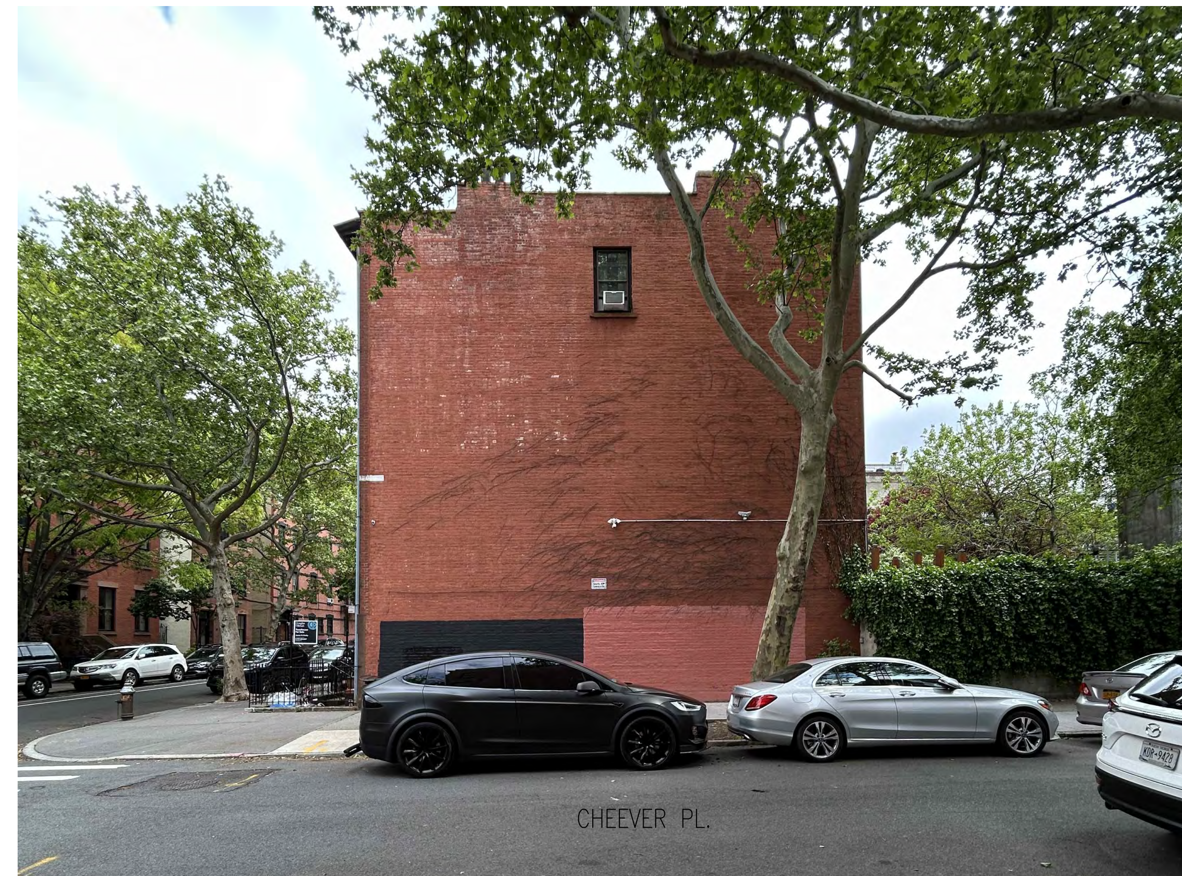
2 EXISTING SIDE FACADE (2024) LPC-001 SCALE: N.T.S.
