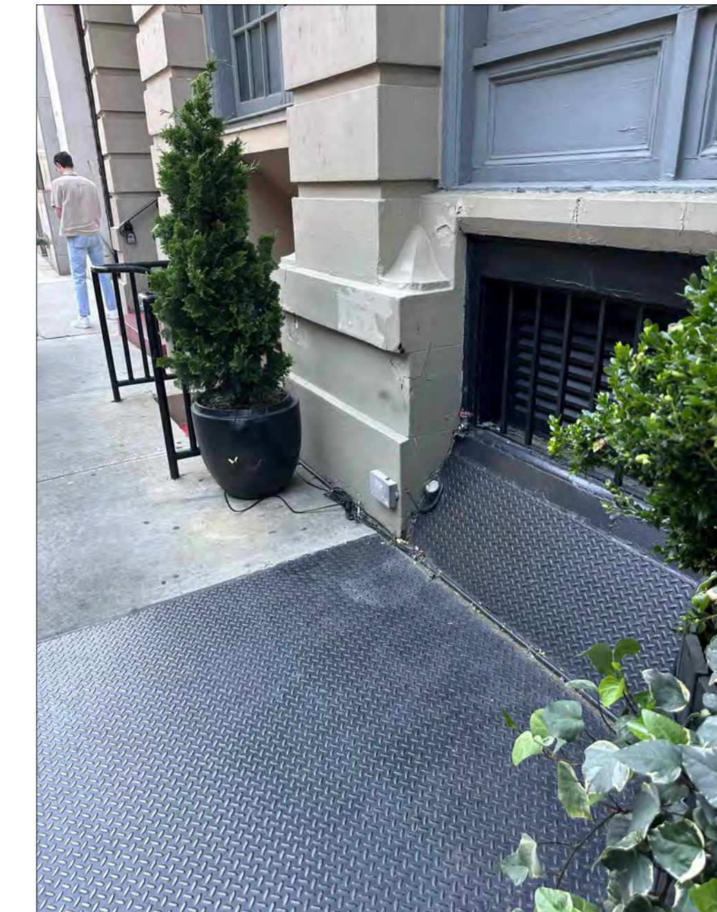
A1 SIDEWALK HATCH SCALE: N.T.S.
