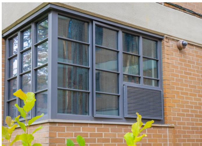
Новые окна, Williamsburg Houses
