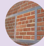
Reparación de ladrillos (restaurar el ladrillo $)
