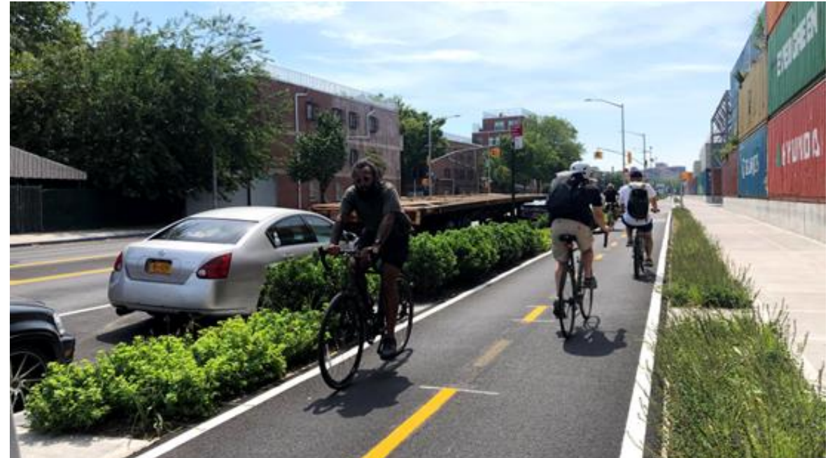
Kent Ave DOT/설계 및 건설부(Department of Design and Construction, DDC) 자본 프로젝트, 2021년
