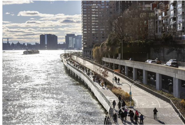
Acceso mejorado a la costa
