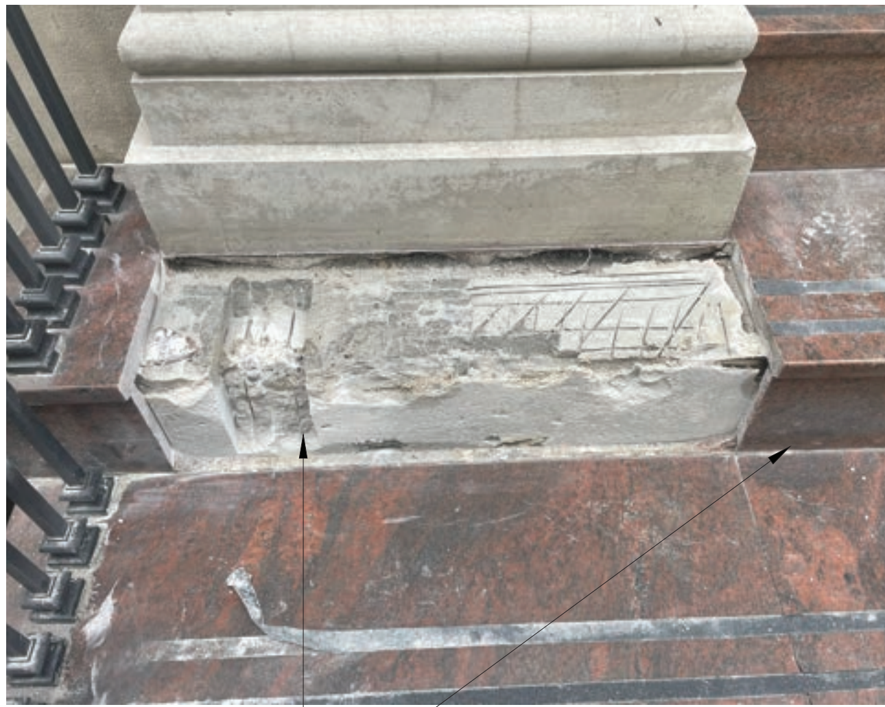
EXISTING CONCRETE FILL
