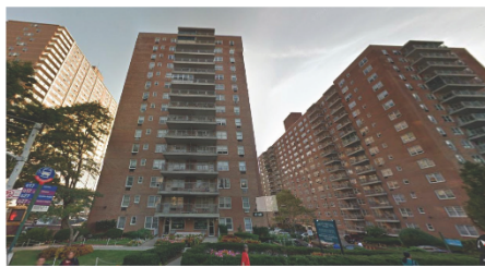
키세나 블러바드가에 위치한 50 세대 이상의 건물
